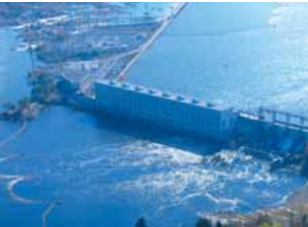
Centrale hydroélectrique des Chutes des Chats Photo de : Alan Todd
