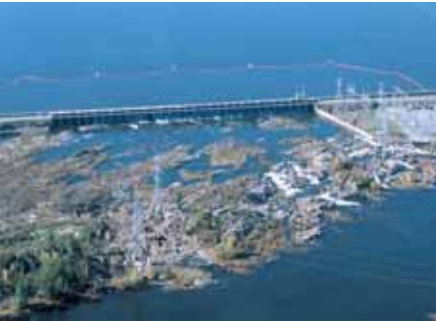
Centrale hydroélectrique des Chutes des Chats – Coté ouest Photo de : Alan Todd
